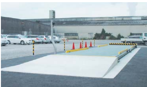
片側スロープの施工例
